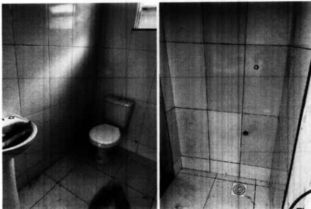
Foto 06 – inclusão dos serviços: revestimento, ponto hidráulico e sanitário.
