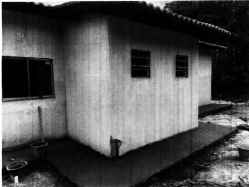
Foto 05 – inclusão de serviços: pintura externa e interna, pavimentação(calçada) e equadria.
