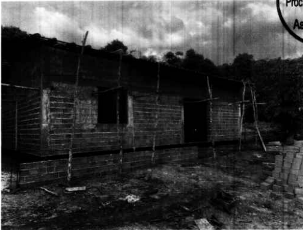
Foto 02 – inclusão de alvenaria para nivelamento da obra.
