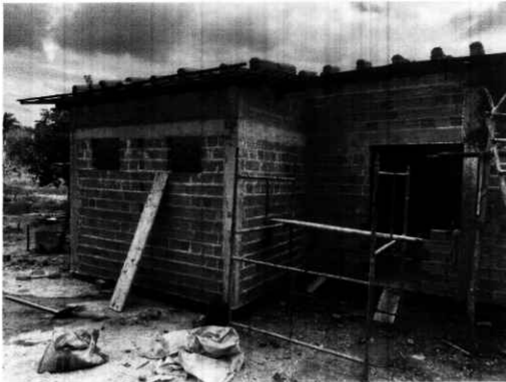
Foto 03 – inclusão de pilares e viga Baldrame e superior, trama de madeira, alvenaria e fundação.
