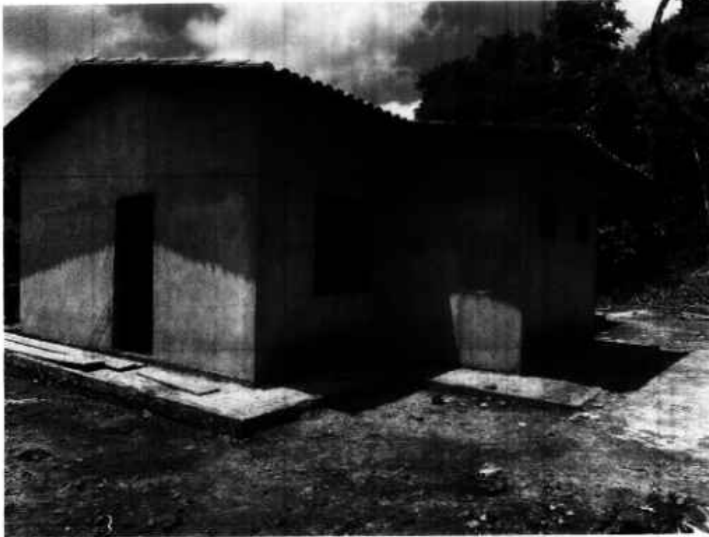
Foto 04 – inclusão de serviços: chapisco, reboco, esquadria e calçada
